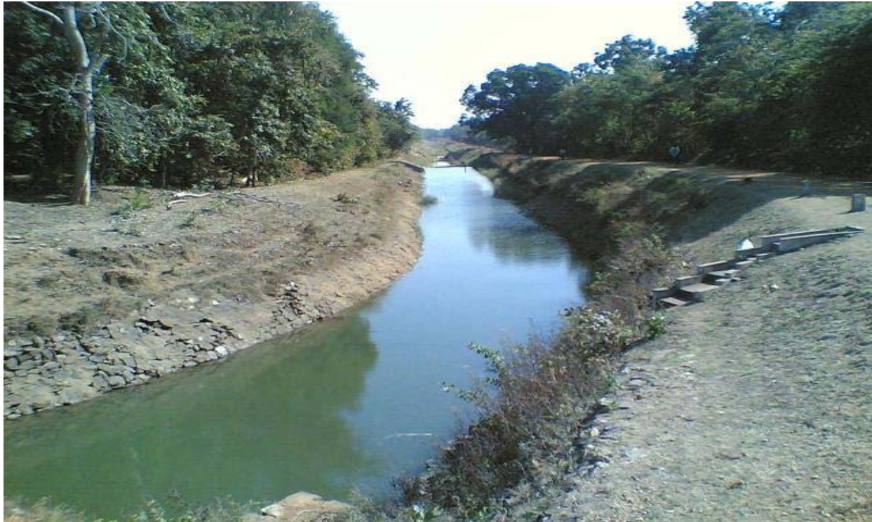
Asolamendha Project Canal
